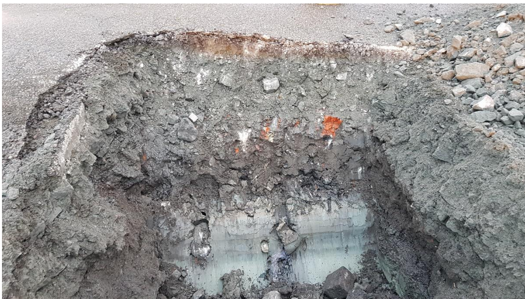
Figur 4. Fotot visar vägg i Pg2013 med typiska grova ytliga fyllnadsmassor underlagrade av muddermassor/lera.
